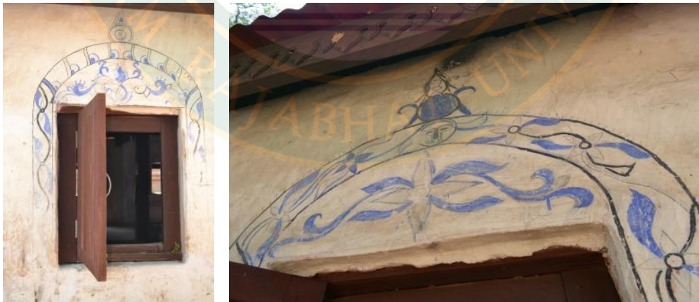
ภาพที่ 4.50 ผนังด้านทิศเหนือ - ทิศใต้ซุ้มโค้งหน้าต่างเขียนลวดลายคล้ายดอกไม้
