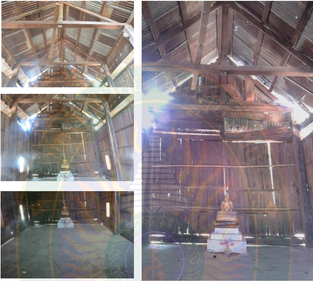
ภาพที่ 4.26 โครงสร้างเสาและโครงหลังคาของสิมวัดสระแก
