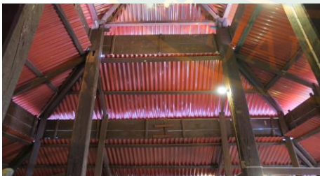
ภาพที่ 4.45 โครงสร้างหลังคาของสิมวัดหลักศิลา
