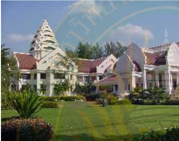
๑) อาคารศูนย์วัฒนธรรมอีสานใต้
