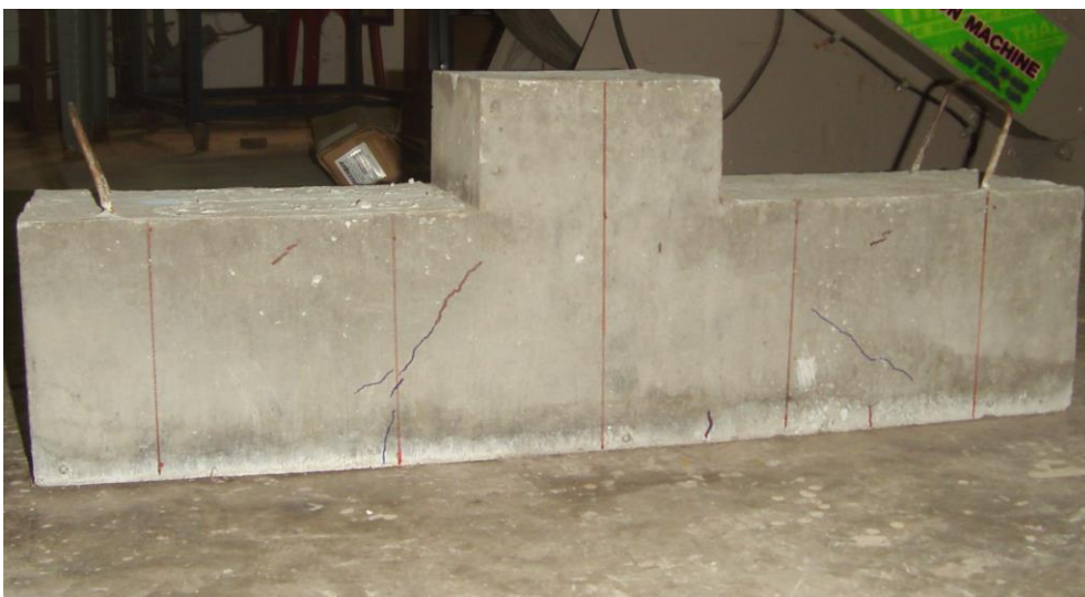
ภาพที่ 6.21 คานคอนกรีตเสริมเหล็กที่หล่อเสร็จแล้ว
