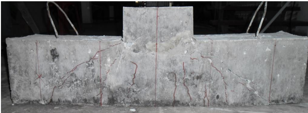
ภาพที่ 4.17 การวิบัติของคานคอนกรีตเสริมเหล็กเนื่องจากแรงเฉือน
