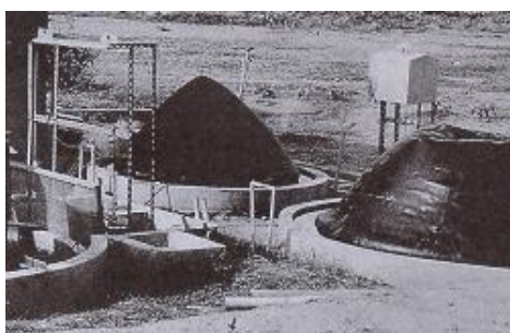
รูปที่ 5 บ่อหมักเร็วแบบบรรจุตัวกลางในสภาพไร้ออกซิเจน (Anaerobic Filter) และแบบยูเอสบี(UASB) (สมชัย จันทรสว่าง, 2545)
