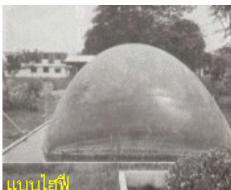
รูปที่ 4 บ่อก๊าซชีวภาพแบบไฮฟี (HYPHI) (สมชัย จันทรสว่าง, 2545)
