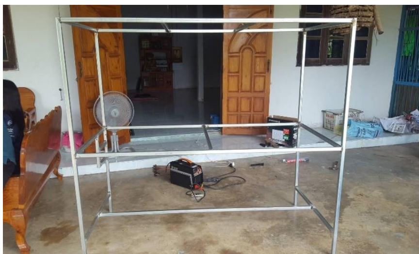
ภาพที่ 3.20 ทาสีโครงสร้างโรงเรือน
