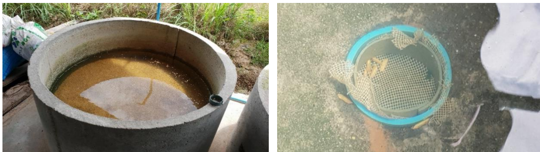
ภาพที่ 5.14 ชุดล้างข้าวและระบบปล่อยน้ำทิ้งของกลุ่มแม่บ้านผลิตข้าวเม่าบ้านน้ำอ้อม
