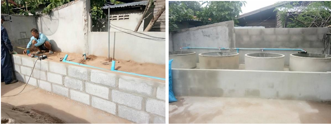
ภาพ ค.7 การก่อสร้างระบบแช่และล้างข้าวเปลือก
